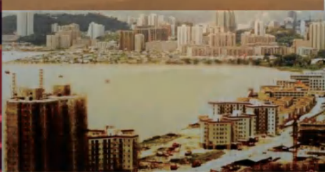
銀海新村第一棟高層社區
